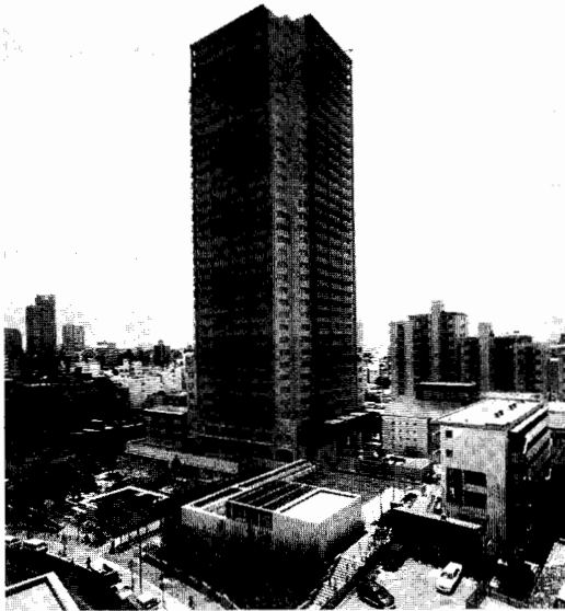
写真一同潤会アパートメントの再開発 〈代官山アドレス〉
