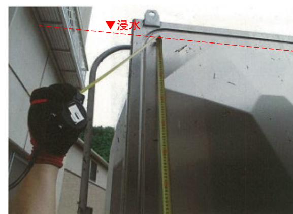
図 1-3-10 (写真) 浸水被害の受水槽・ポンプ室
