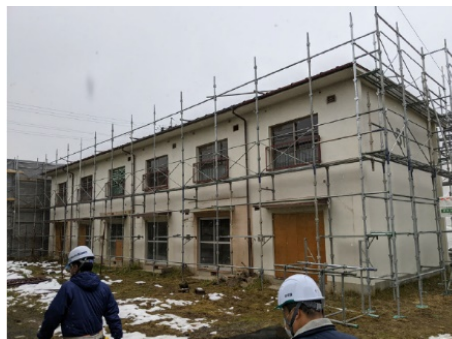
写真3 解体工事の様子
