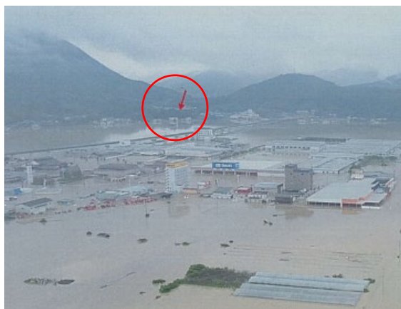
図 1-3-11 (写真) 周辺の状況
