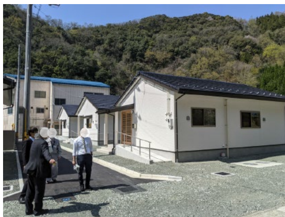
②手前からD棟、E棟、F棟
