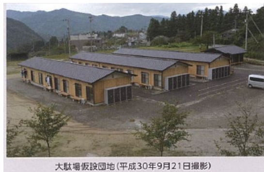
大駄馬仮設団地 (平成30年9月21日撮影)
