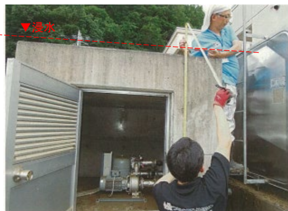
図 1-3-10 (写真) 浸水被害の受水槽・ポンプ室
