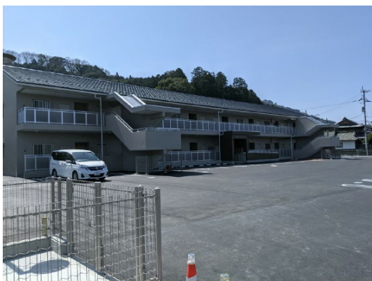
共用片廊下外概観
