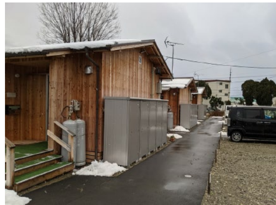
写真 3 3号棟妻側通路
