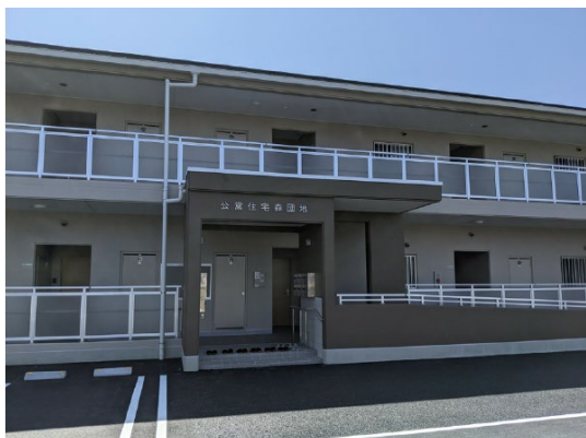
住棟エントランス
