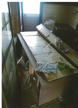
住戸内の被害(台所)
